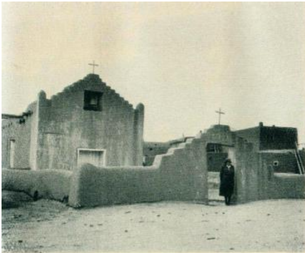
Die neue Missionkirche im Indianerdorf El Taos
